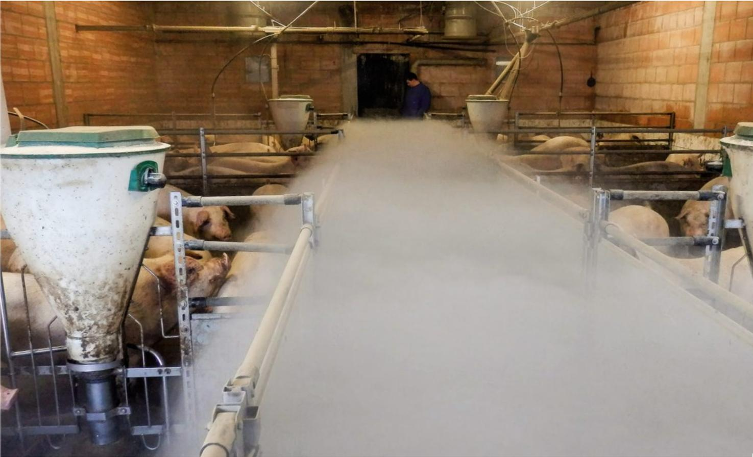
Ein regelmäßiger Lüftungscheck mit Vernebelung hilft: Korrekt eingestellte und gut funktionierende Technik ist entscheidend für einen niedrigen Energieverbrauch.
